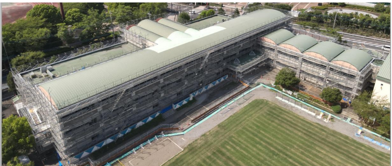
鴻巣中央小学校：R7年度実施（屋上防水等改修工事）
