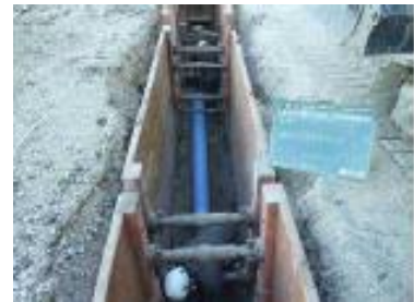
整備例(下水道管渠) 開削工法
