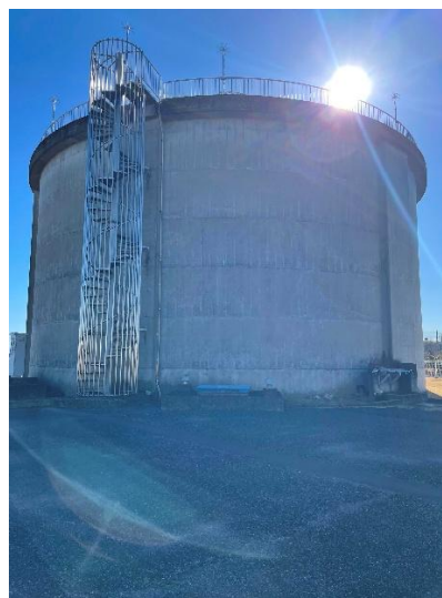
吹上第二浄水場 NO. 3 配水池
