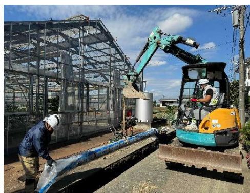
配水管布設状況
