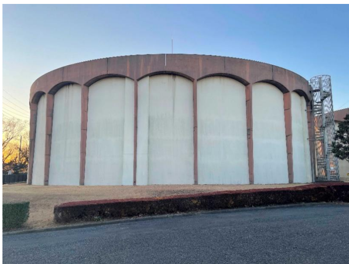
馬室浄水場 NO. 2 配水池
