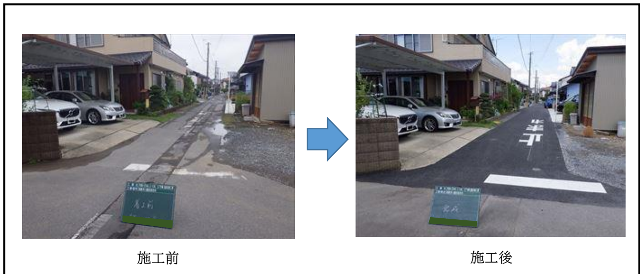
【市道の舗装打換え工事】
