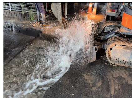
漏水修繕工事
