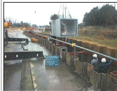
整備例(下水道函渠) 開削工法
