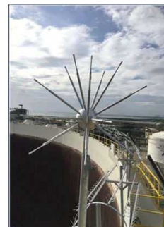
ボール型電荷放散器
