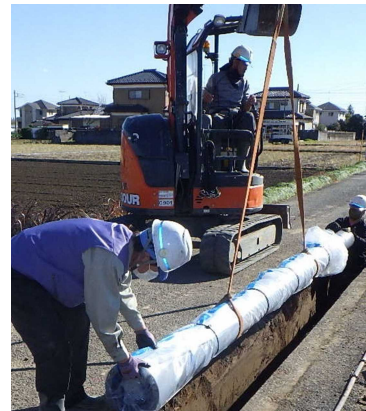
配水管布設状況
