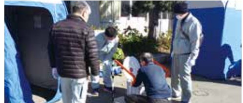
▲マンホールトイレを設置している様子
