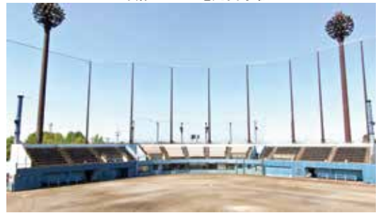
▲新しく整備された防球ネット(高さ30m)
