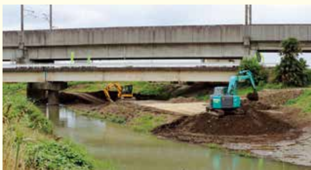
現在、進められている元荒川の溢水対策工事
