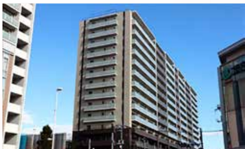
鴻巣駅東口駅通り地区再開発ビルが完成（7月）
