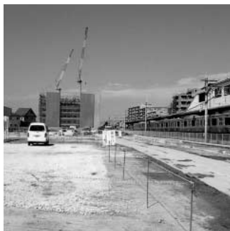
工事中の北鴻巣駅西口駅前
