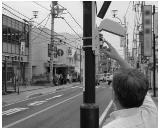
節電対策に一役！街路灯に設置されたスイッチ
