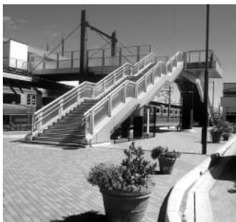
北鴻巣駅西口の自由通路 及び昇降階段
