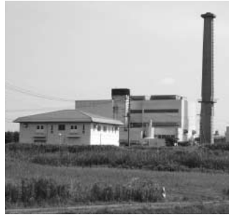
吹上地域のゴミ処理場 小針クリーンセンター
