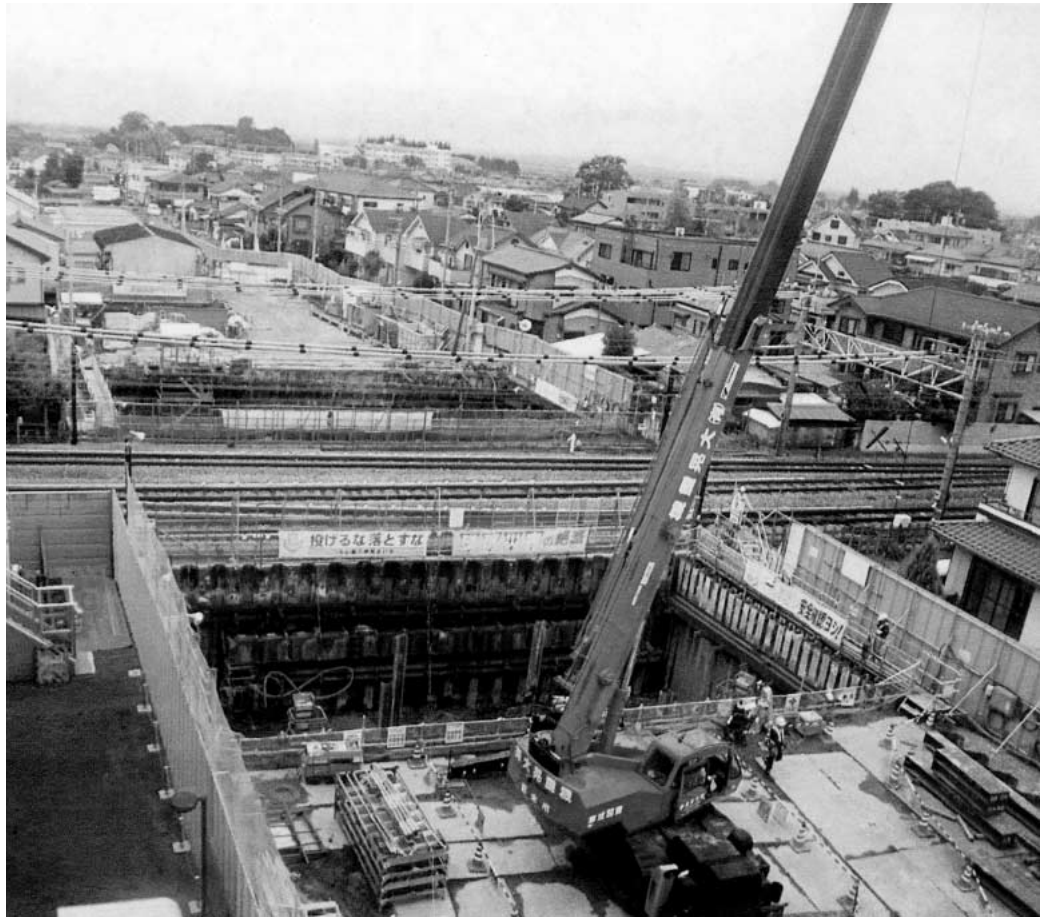
JR高崎線アンダー部分工事（三谷橋大間線）
