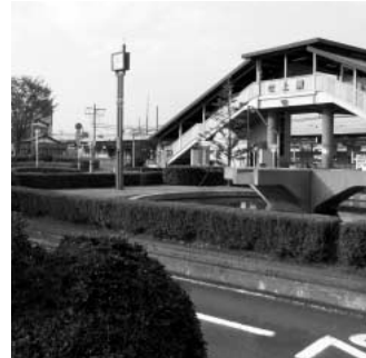
早期着工が望まれる 吹上駅南口駅前多目的広場整備
