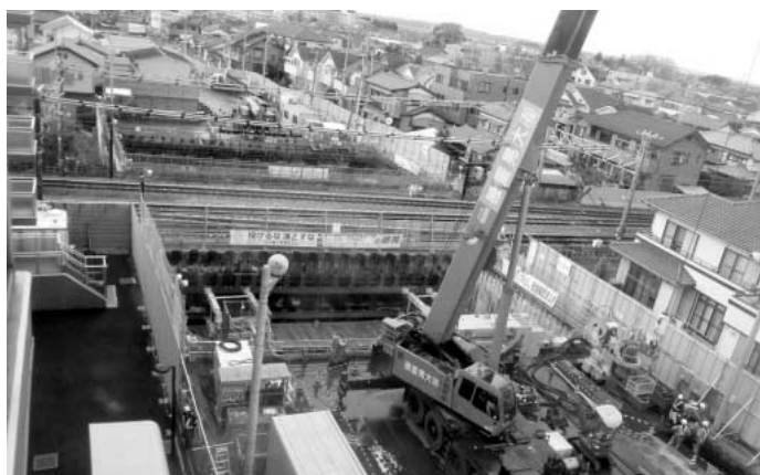
三谷橋大間線工事
