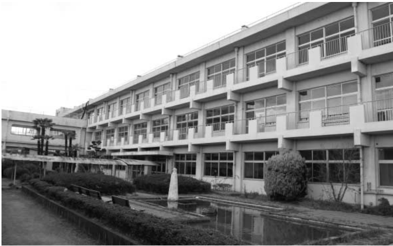
解体される吹上中学校校舎
