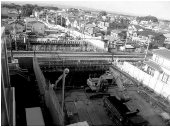
工事中の三谷橋大間線
