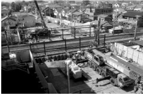
三谷橋大間線ご道橋新設工事
