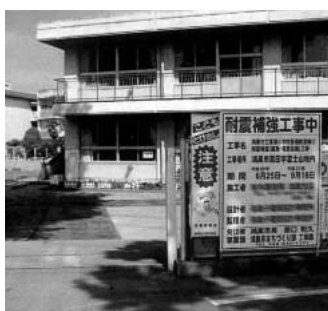
耐震工事が行われた箕田小
