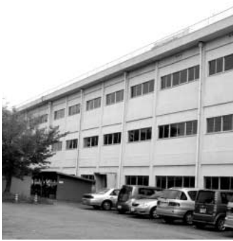
解体を待つ吹上中普通教室棟
