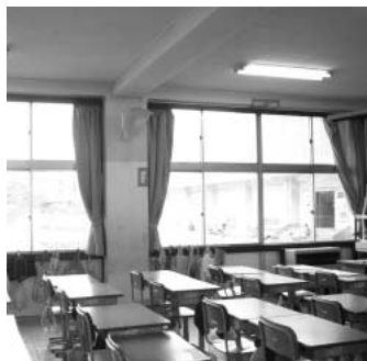
耐震補強工事前の箕田小学校教室
