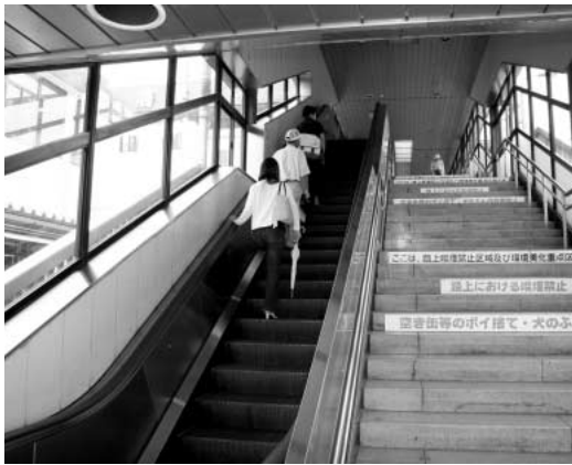
鴻巣駅東口自由通路エスカレーター
