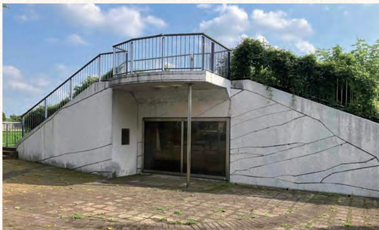
石田堤の断面展示施設
