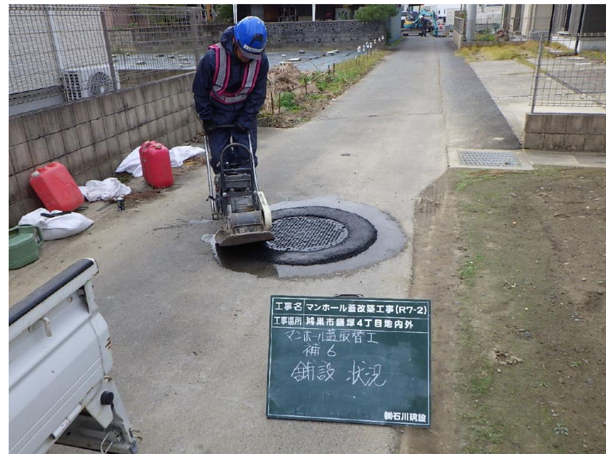
写真：円形工法によるマンホール蓋取替工事
