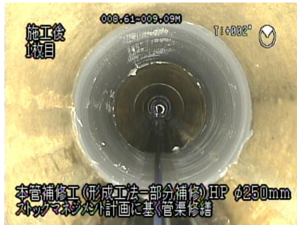
写真：修繕後の管内
