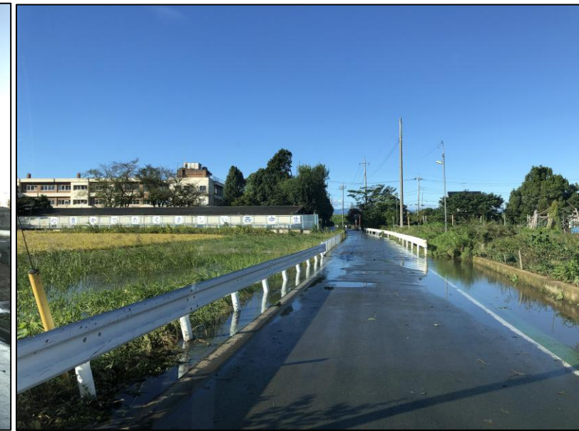
写真：令和元年東日本台風冠水・浸水状況
