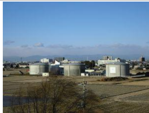
吹上第二浄水場
