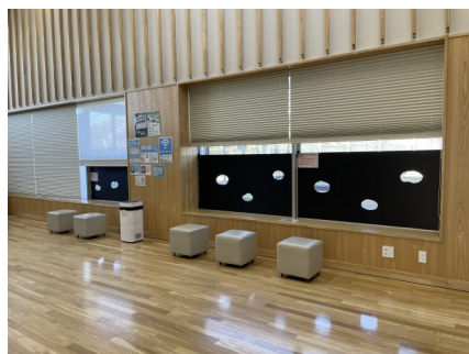
目隠し設置中
