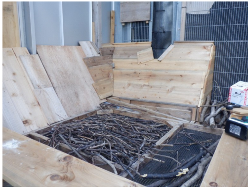
斜めの壁完成！
