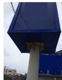
支柱・広告板接合部
