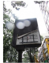
シート材がはがれかかった状態
