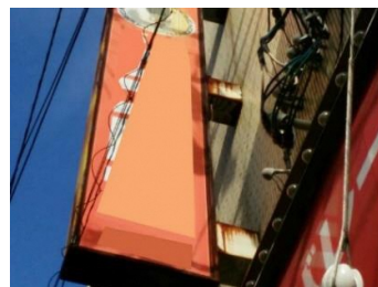
ブラケット・取付部の腐食（ブラケットカバー）
