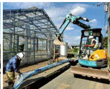
地震に強い耐震管への更新
