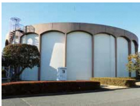
浄水場施設の耐震化(馬室浄水場)
