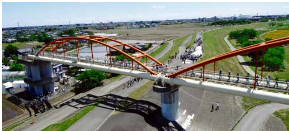
※荒川水管橋は埼玉県（企業局）所管の施設です
