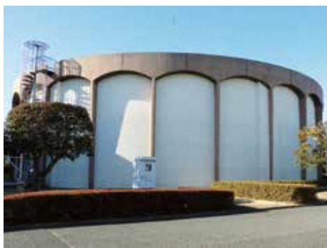
浄水場施設の耐震化(馬室浄水場)
