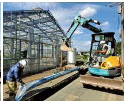
地震に強い耐震管への更新
