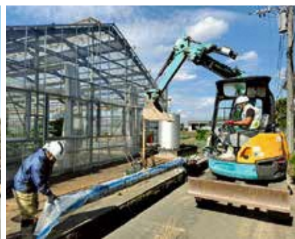
地震に強い耐震管への更新
