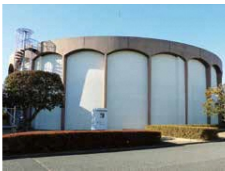
浄水場施設の耐震化(馬室浄水場)
