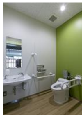
【多目的トイレの設置】
