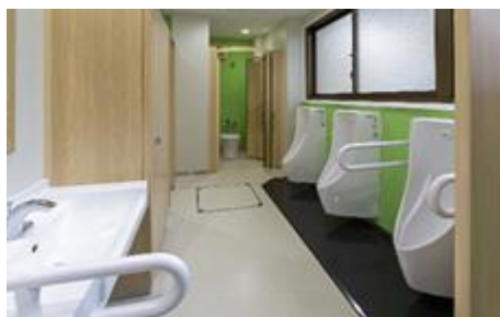
【トイレ改修工事】
