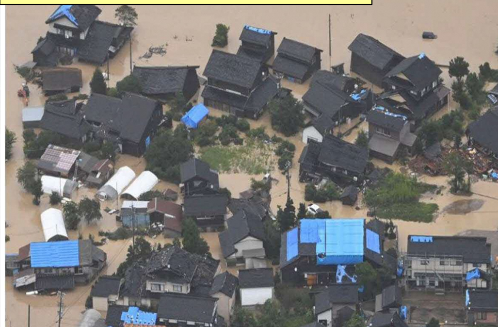
輪島市の大雨で浸水した住宅街 (21日午後4時頃)
