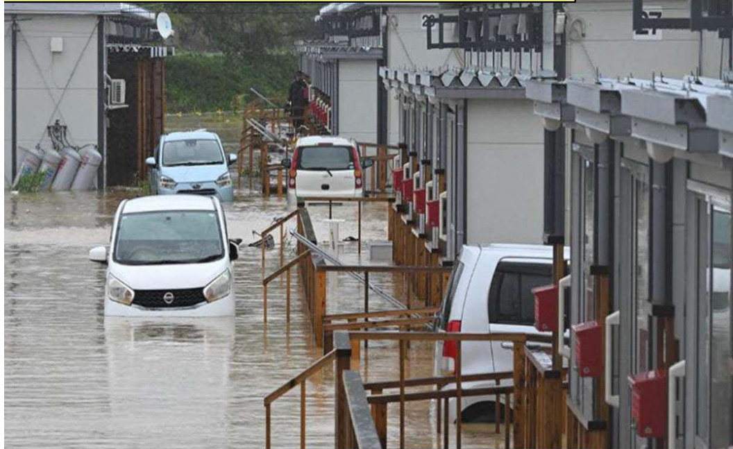
大雨で浸水した輪島市の仮設住宅 (22日午前9時頃)
