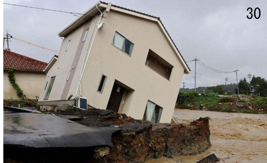
珠洲市の濁流によって傾いた住宅 (22日午前11時頃)
