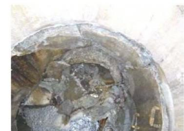
マンホールと管きょの接合部破損
