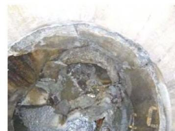
マンホールと管きょの接合部破損
