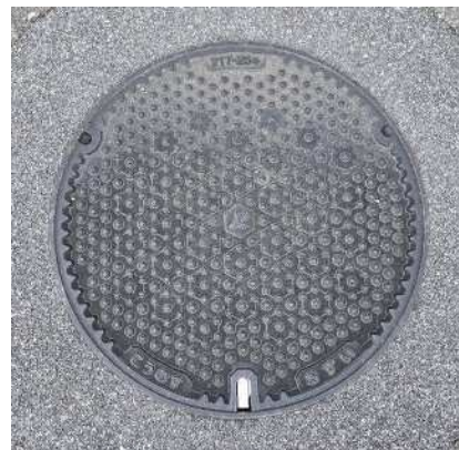
図 7 污水のマンホール
