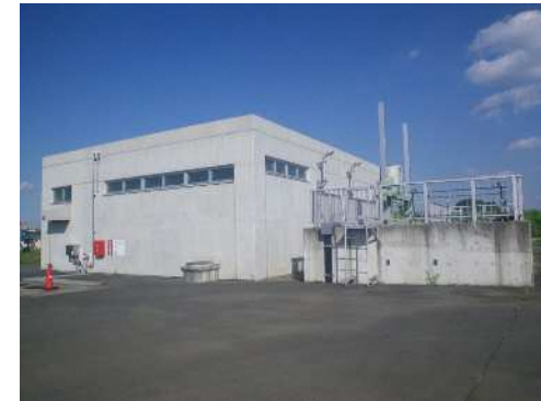
図 23 大間雨水ポンプ場
