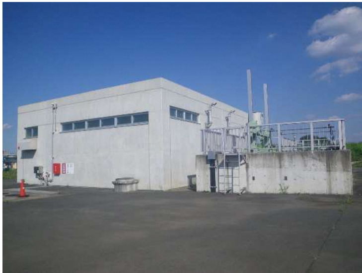
大間雨水ポンプ場
