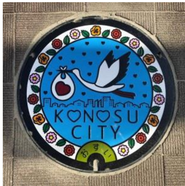
図 7 污水のマンホール
