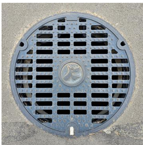
図 8 雨水のマンホール
