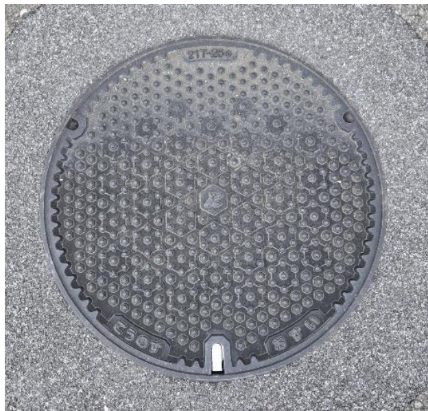
図 7 污水のマンホール
