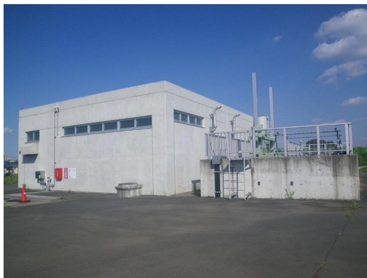
図 23 大間雨水ポンプ場
