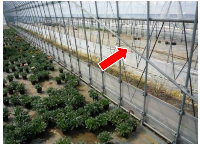
サイド部の補強（筋交い）
