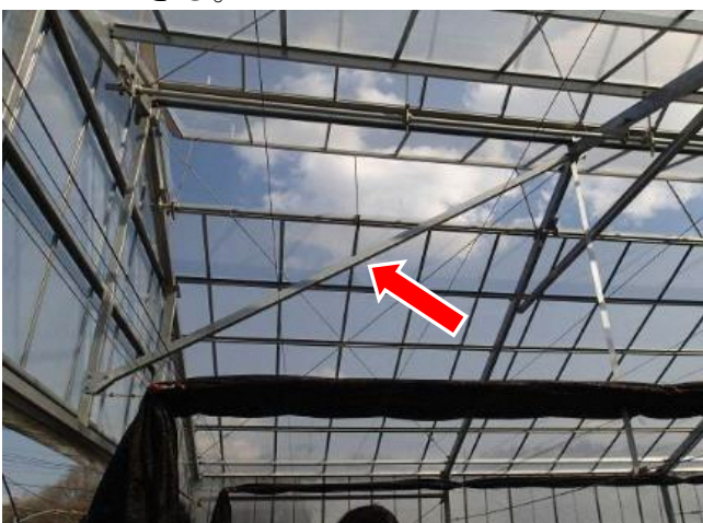
妻面と屋根の補強（角パイプ）
