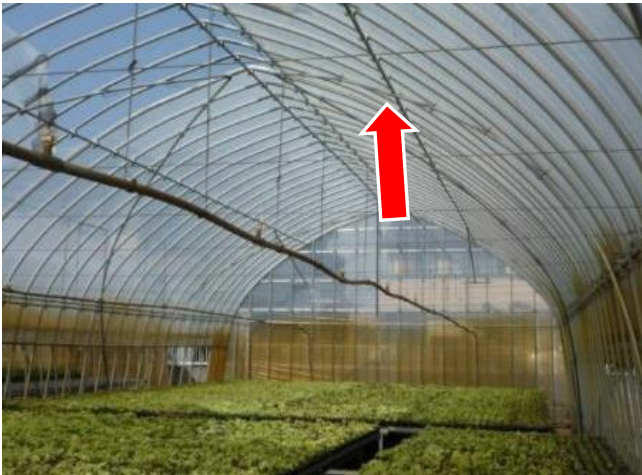
屋根の補強（母屋パイプ）
