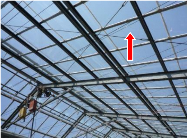
屋根材の補強：X字状に設置
