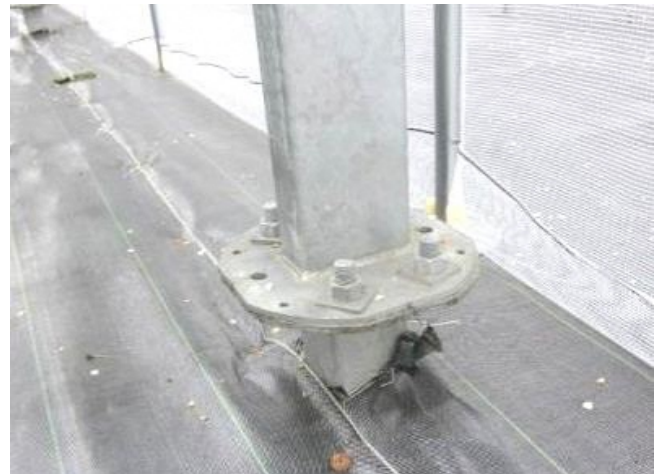
鉄柱基礎（鉄柱打ち込み：約1 m）
