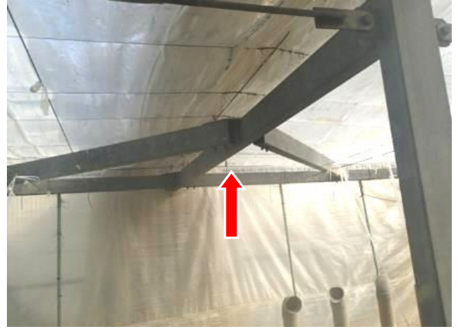
梁と柱の補強（角パイプ）
