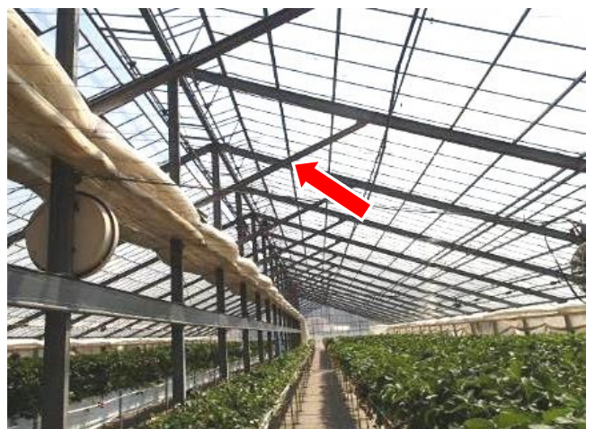
屋根と柱の補強（角パイプ）
