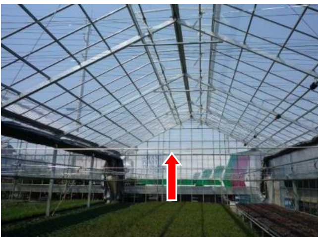
柱材の補強：梁状に設置
