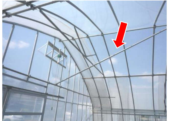
妻面と屋根の補強
