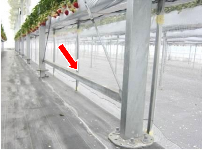
柱と柱の補強（角パイプ）
