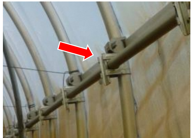
接合金具（鉄板製）
