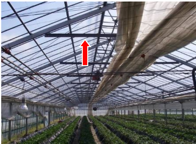
屋根材の補強：アングル鋼材タイバー
