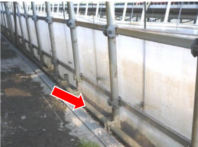
沈下防止パイプ
