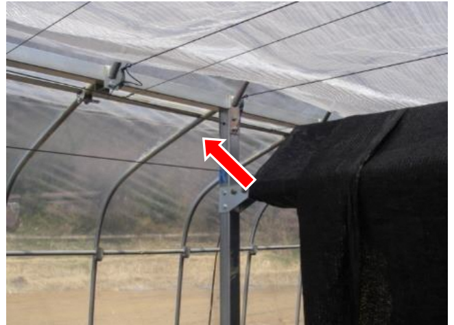
柱と梁を補強
