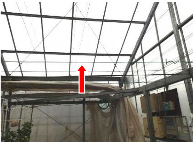
妻面に設置（ワイヤー）
