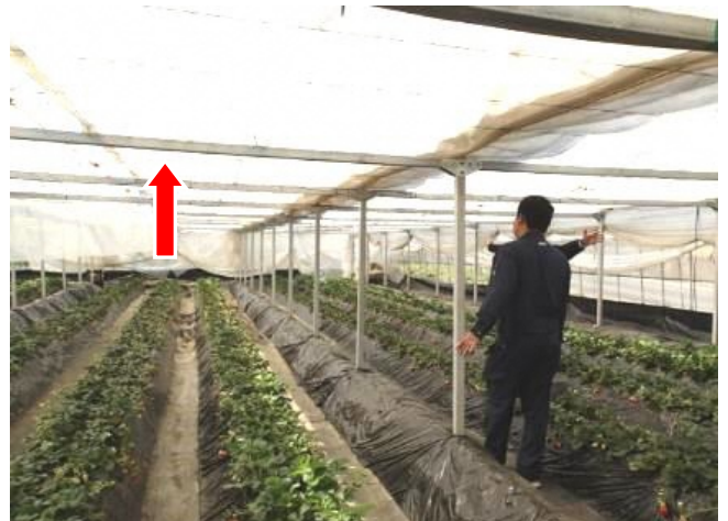
柱材の補強：角パイプ鋼材陸梁
