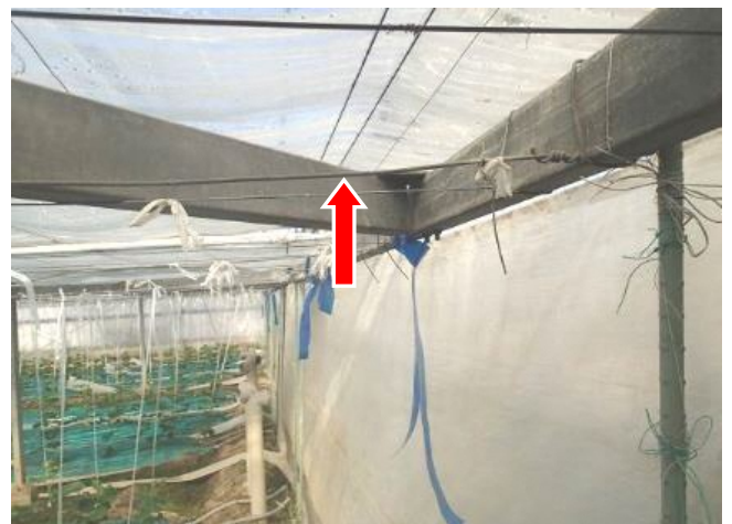
梁材に設置（ワイヤー）
