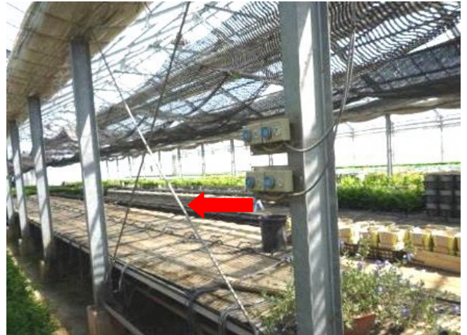
柱材の補強：X状に設置
