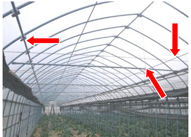
タイバーと屋根と妻面の補強
