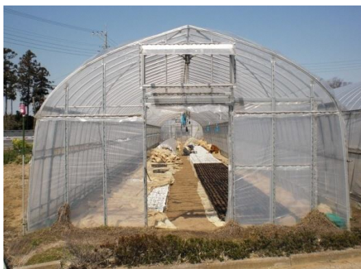
屋根勾配が大きいハウス
