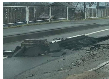
令和6年能登半島地震における下水道施設被災状況
