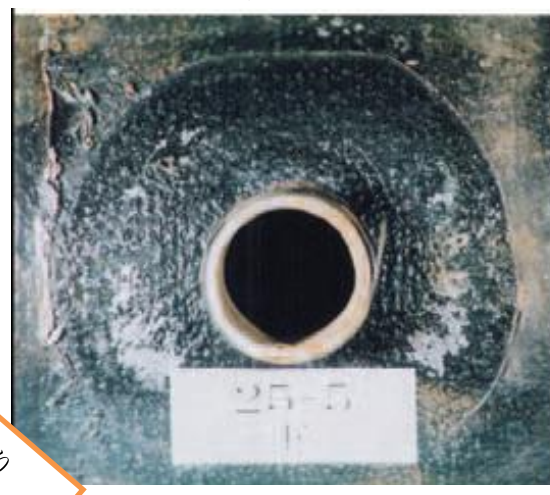
密着型コアを挿入した穿孔口
