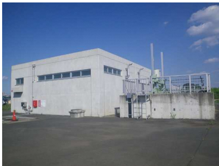
図 24 大間雨水ポンプ場
