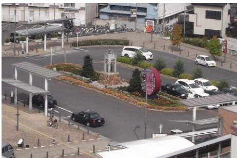
吹上駅北口駅前広場
