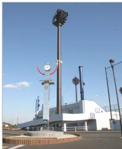
上谷総合公園 (上谷地区)
