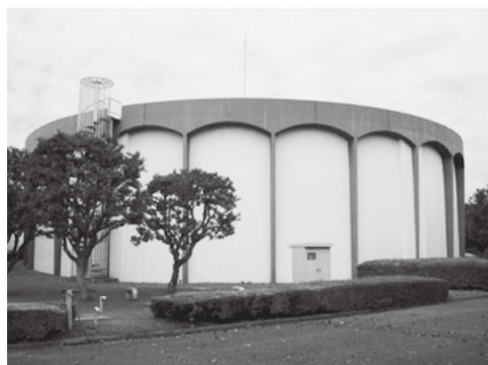
■ 配水池 (馬室浄水場)
