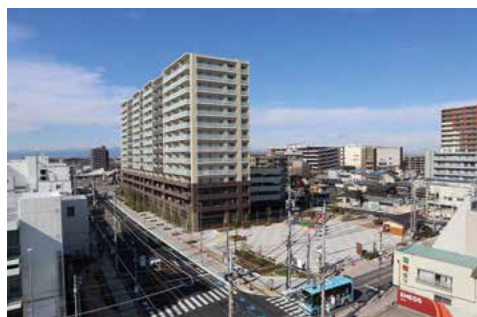
鴻巣駅東口駅通り地区再開発事業地内
