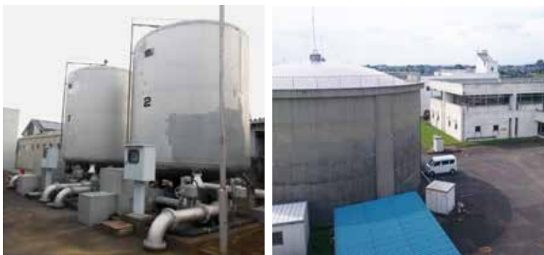
浄水場には、安全できれいな水を24時間365日供給するために、ろ過装置や配水ポンプなどのたくさんの機械があります
