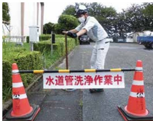
▲配水管の内部に付いた鉄分等を排出します
