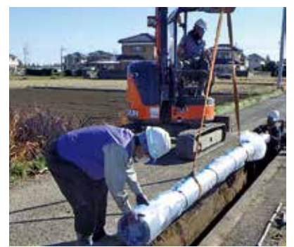
計画的に耐震管への更新工事を実施
