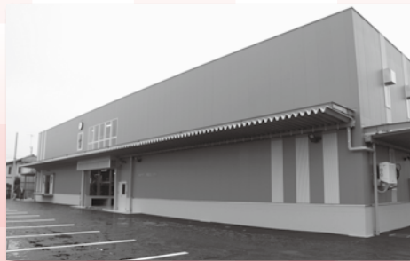
市役所敷地内に防災備蓄センターが完成 (11月)
