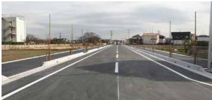
新たな開通部分
