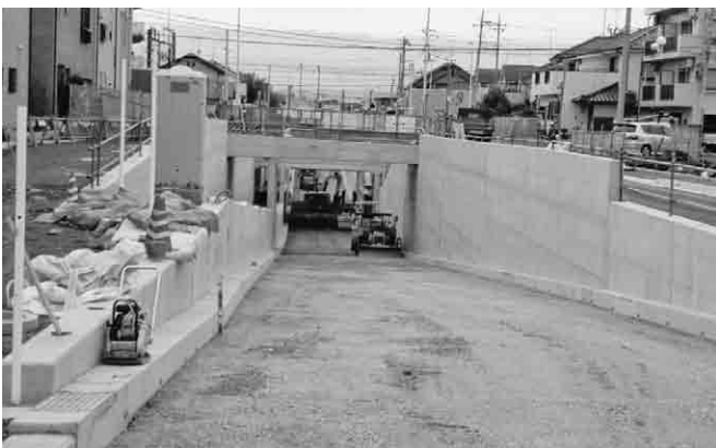
供用開始間近の三谷橋大間線
