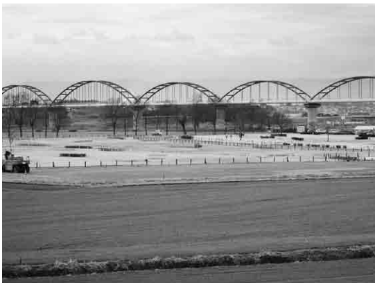
増設工事が進む吹上パークゴルフ場
