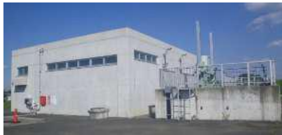
大間雨水ポンプ場
