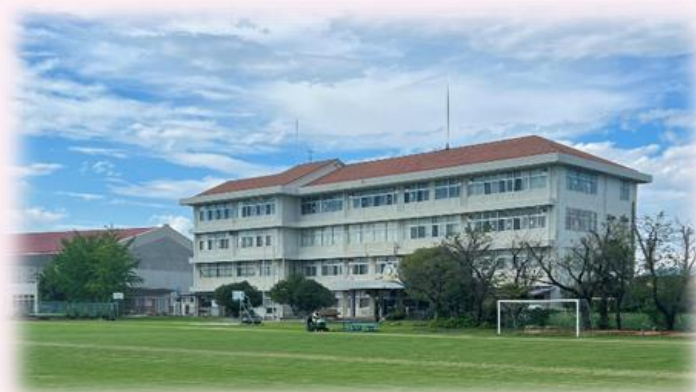
教育支援センター移転先（現：小谷小学校）
