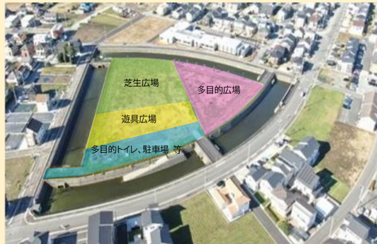
(仮称)北新宿近隣公園整備事業予定地
